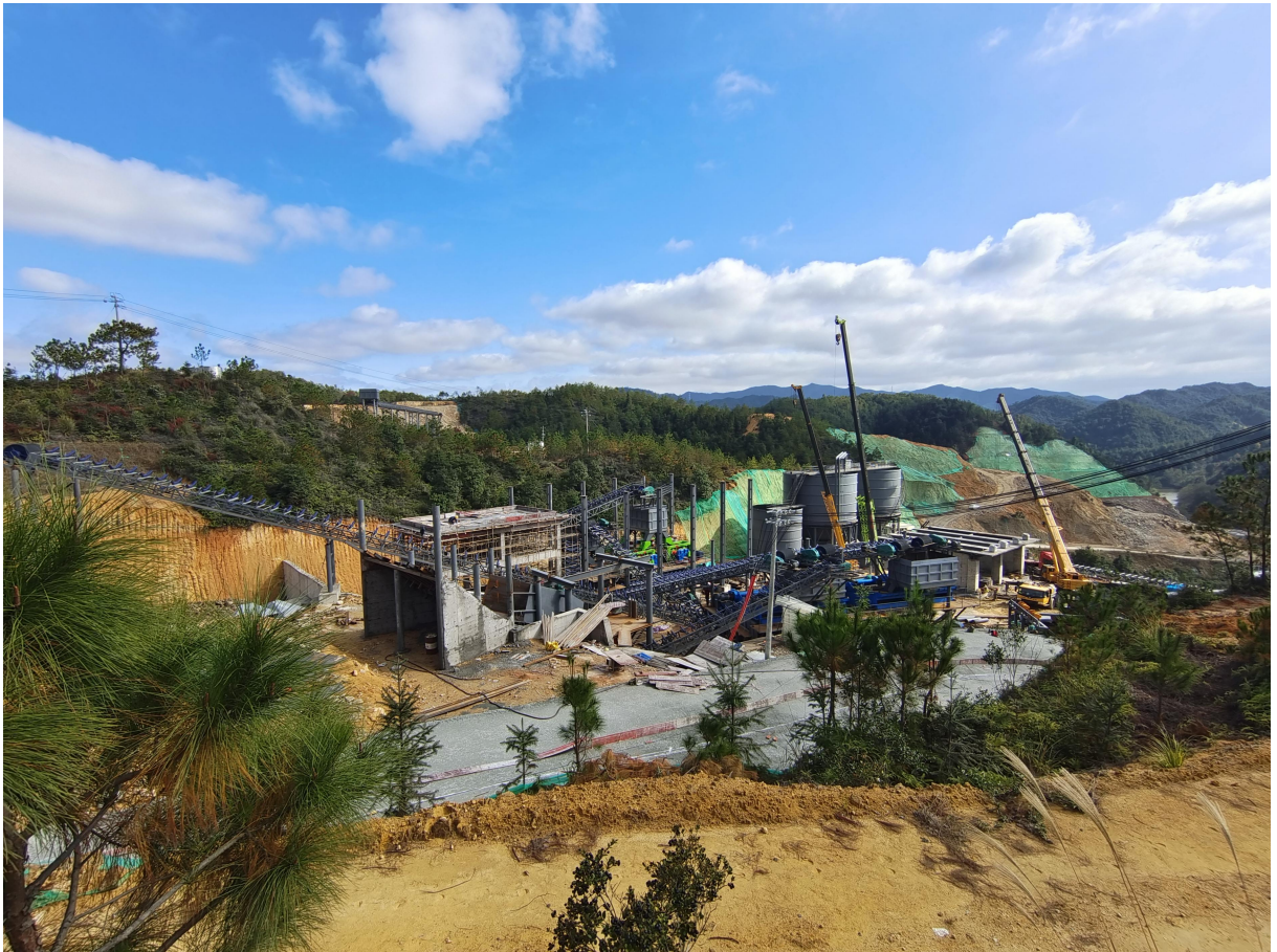
图 2-5 机制砂生产车间 A 区现场情况图
